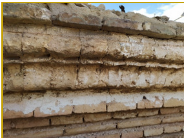
Detalle de cornisa en calle Feria, incisiones sobre capa de cal, simulando las líneas de ladrillo,
